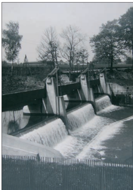
Das Stauklappenwehr in Flöha-Plaue in den 20er Jahren. Bild: Archiv Christian Rößler
