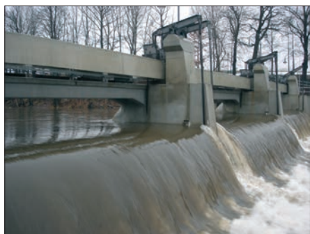
Wehranlage Plaue nach der Sanierung. Bild: Christian Rößler
